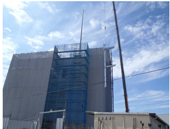
ゲート③利用 鉄骨階段建て方
