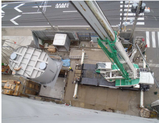
ゲート②利用 防火水槽設置
